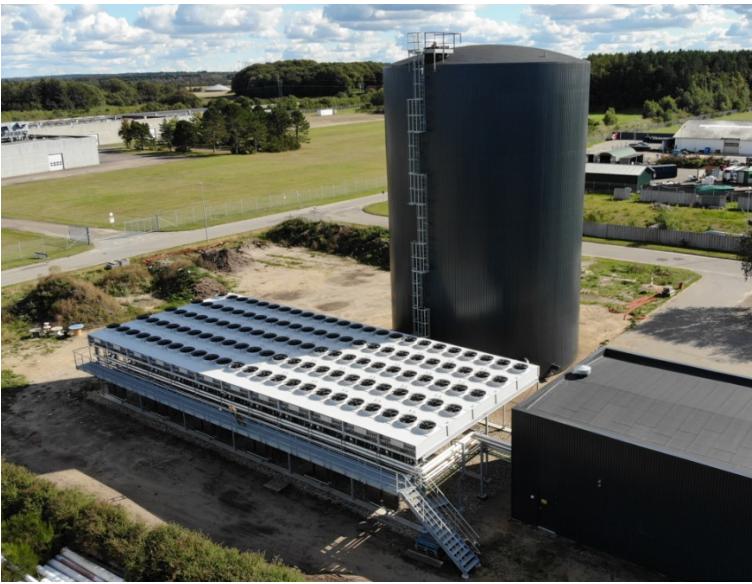
Figur 5: Et eksempel på et luft-til-vand varmepumpeanlæg på 3,5 MW fra Sdr. Felding Fjernvarme
